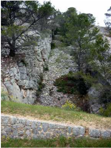
Fossé de la branche n°3 (photo de l'auteur).
