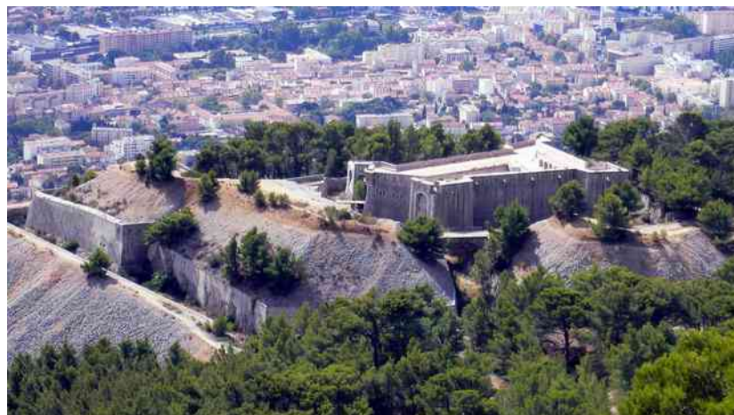
Vue de l'enveloppe dressée à l'est et au nord du fort Faron et de sa batterie d'artillerie (photo de l'auteur)
