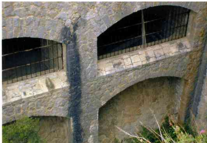
détail des embrasures de tir de la casemate du 1 er flanc
